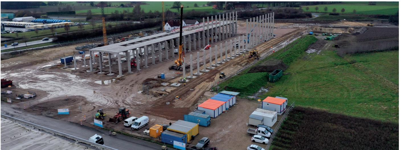
Das Gebäudeensemble auf der Baustelle im IBV ist schnell in die Höhe gewachsen. Zu Jahresbeginn geht es an den Kranbahnen und Stahlfachwerkträgern für das Hallenschiff weiter.
