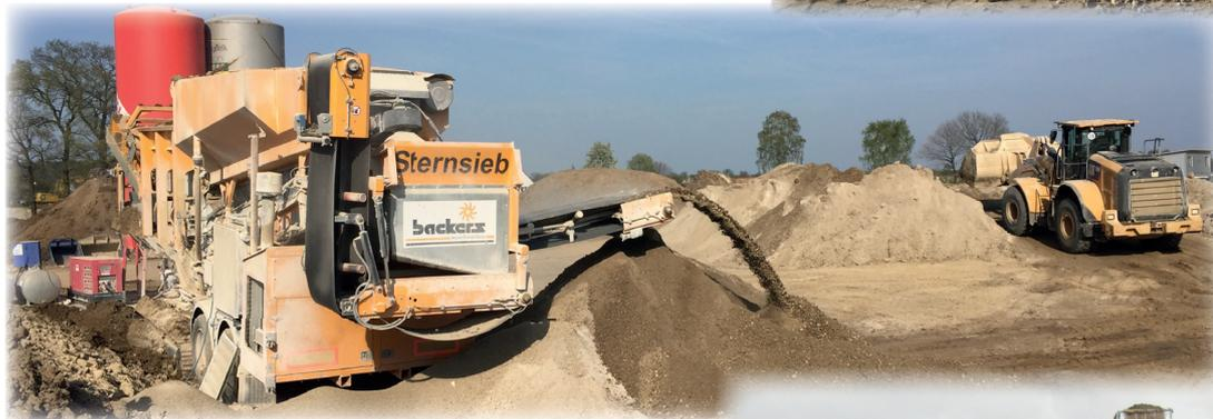
Mittels Radlader wird der stabilisierte Boden auf Halde abgelegt.
