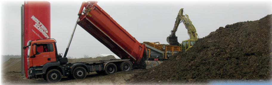
Der Aushub wird per LKW einige Hundert Meter gefahren und vom Bagger auf die Sternsieb- und Mischmaschine gefüllt.
