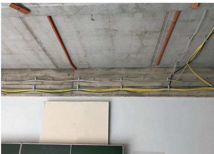
Die Sanierung der Decken wurde mit dem Verlegen von Leitungen kombiniert.
