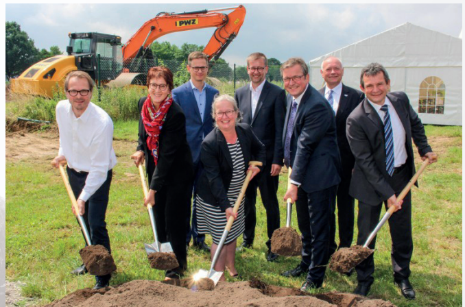
Mit dem ersten Spatenstich beginnt der Bau des neuen ILH-Forschungsgebäudes (Foto: Universität Paderborn)
