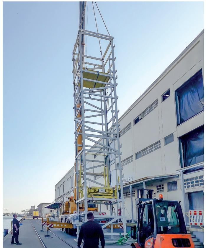
Vertikalförderer Montage an der Gebäudeaußenseite
