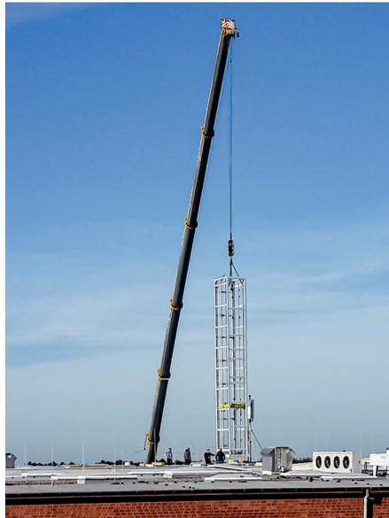
Die Montage des Vertikalförderer erfolgte über eine kleine Öffnung im Dach und wurde binnen weniger Stunden durchgeführt
