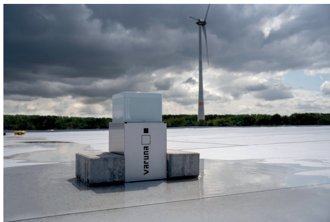
Windsogsicher montiert: Zwei Gewichte sorgen für die nötige Auflast - ohne die Dachhaut zu beschädigen.
