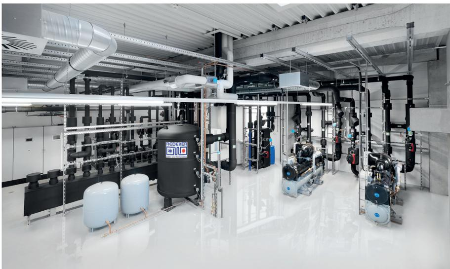
Kältezentrale mit Schraubenverdichtern, Kältespeicher- und verteilung sowie Schaltschränken
