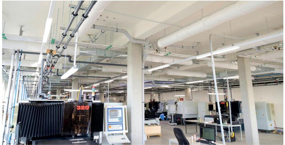
Textile Quellluftschläuche garantieren zugfreie und gleichmäßige Luftverteilung
