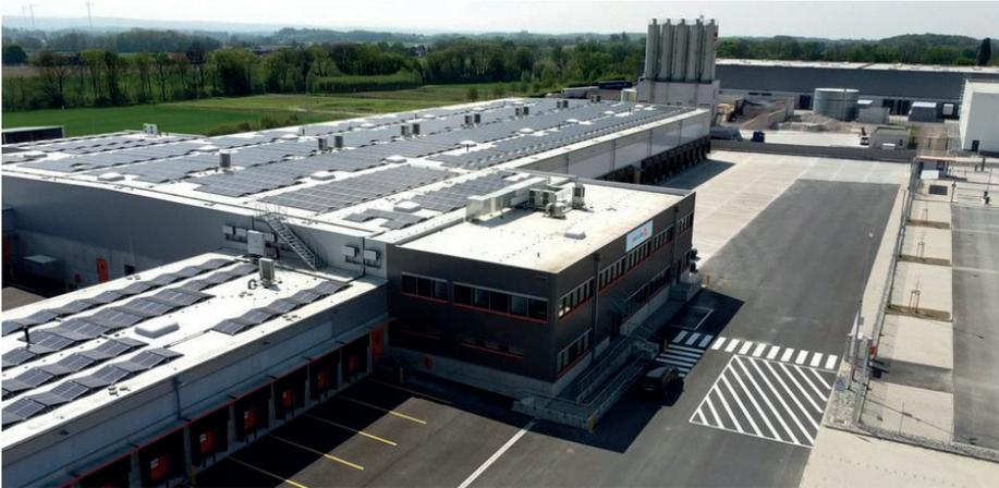
Fast 100 Prozent seines Stroms bezieht trans-o-flex aus regenerativen Energiequellen. Teilweise wird Strom sogar mit Photovoltaikanlagen selbst produziert, wie hier auf dem Dach des Sortierzentrums im westfälischen Hamm-Rhynern. Im Luftbild auch erkennbar ist die Y-Form der Anlage, die viele Ladetore bei geringem Flächenbedarf ermöglicht.
