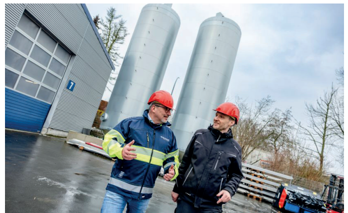
Frank Wehrmann (links), Geschäftsführer von Wehrmann Transport, und Gebäudemanager Matthias Gering inspizieren die beiden Pufferspeicher, die mit elf Metern Höhe jeweils ein Volumen von 45.000 Litern fassen.
